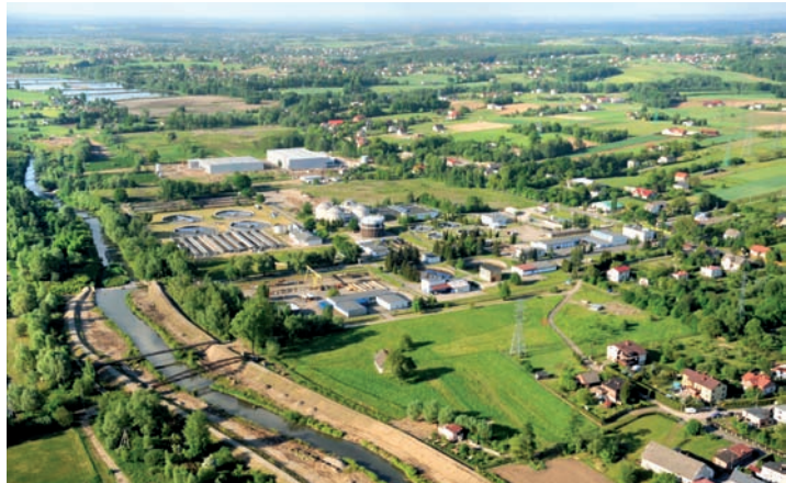
Oczyszczalnia Ścieków w Komorowicach
